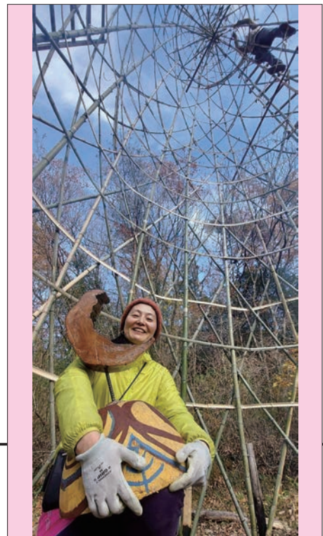
建設中の「月の塔」→
